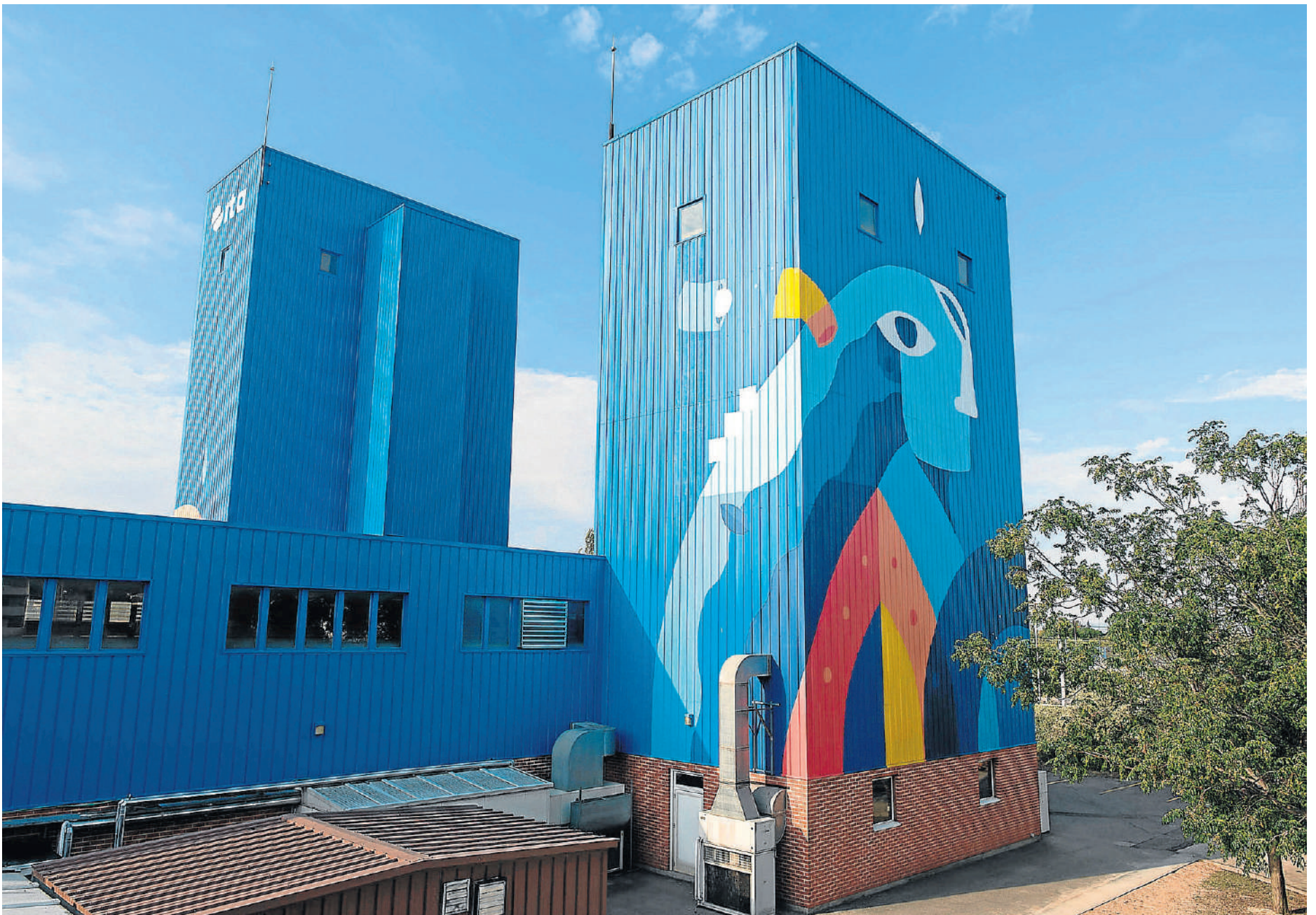
El ITA dispone como instalaciones singulares de dos torres de ascensor, en las que realizan ensayos de componentes de elevación. FRANCISCO JIMÉNEZ
